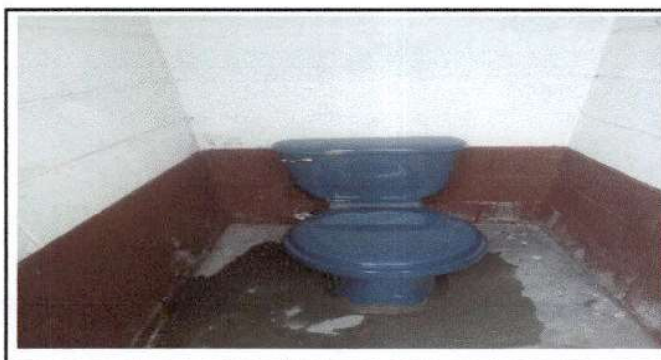
Foto 6: Sustitución de hinodorro completo.
