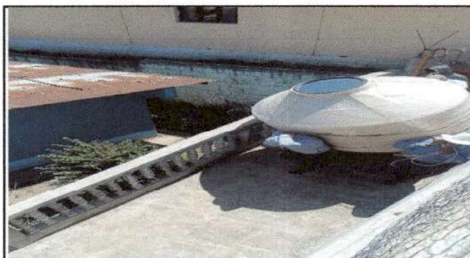
Foto 4: Instalación de deposito.
