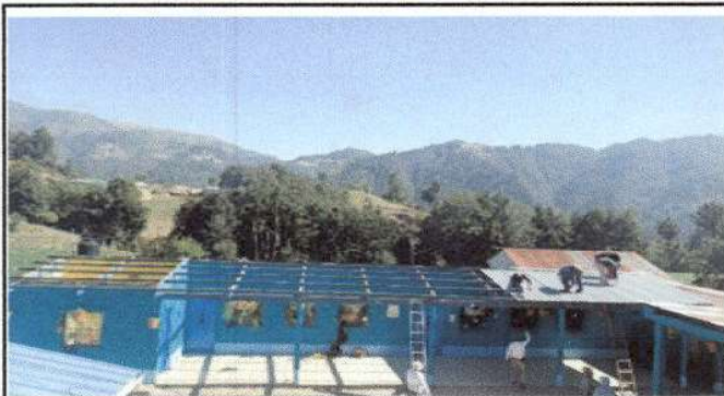
Foto1: Cambio de lamina troquelada.
